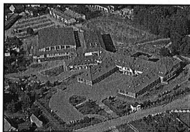
Obiekty sportowe w Twardogórze
