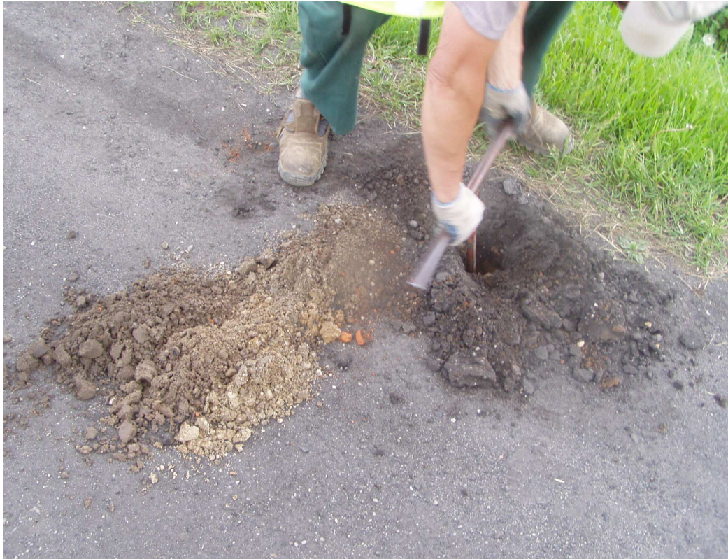
Wykonywanie odwiertów w istniejącej nawierzchni drogi Odwiert nr 2 str. L, km 0+250
