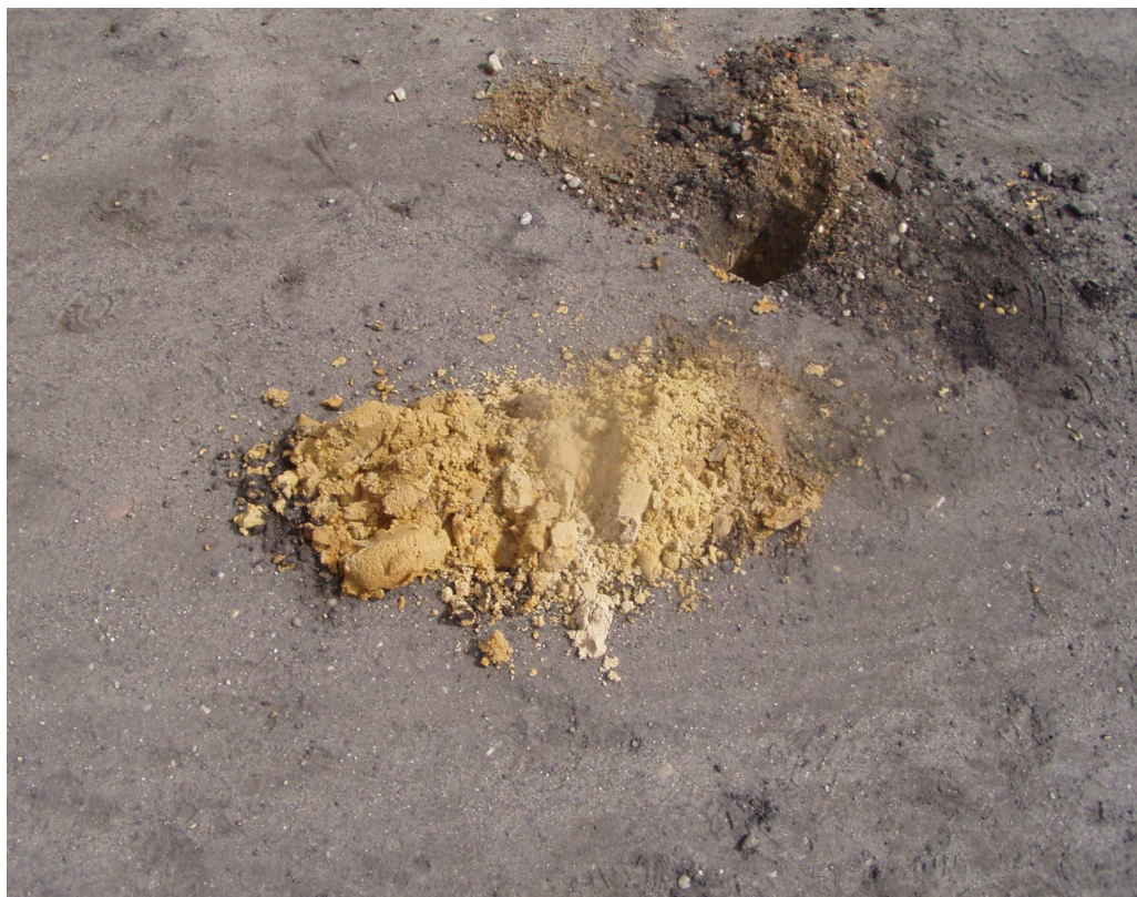
Wykonywanie odwiertów w istniejącej nawierzchni drogi Grunt (10cm H//szlaka + 90cm Pr + 30cm Pd mokry)
