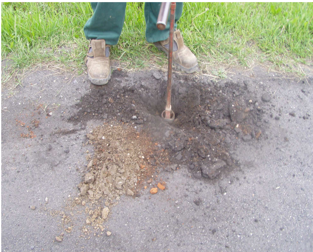
Odwiert nr 2 str. L, km 0+250 Odwiert ręczny
