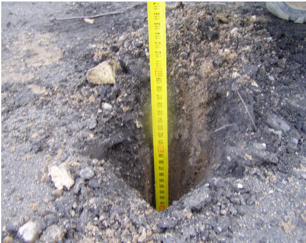
Odwiert nr 5 str. L, km 0+950 Odwiert do głębokości 2,5m p.p.t. (na 1,1m woda)
