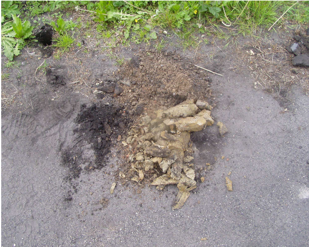
Wykonywanie odwiertów w istniejącej nawierzchni drogi Grunt (20cm H//szlaka + 50cm H//Pr + 50cm Pog + 130cm G pl. )
