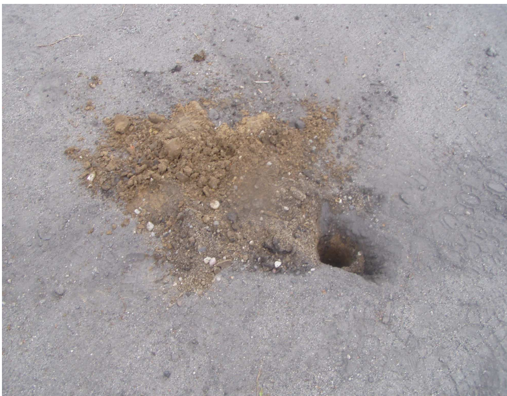
Wykonywanie odwiertów w istniejącej nawierzchni drogi Grunt (20cm H//szlaka//tłuczeń + 190cm Pog + 40cm G tpl. )
