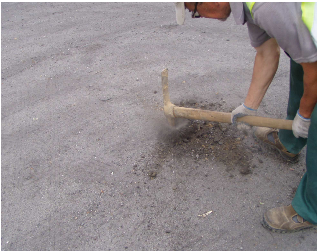
Wykonywanie odwiertów w istniejącej nawierzchni drogi Odwiert nr 1 str. P, km 0+020
