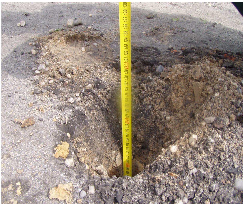
Odwiert nr 4 str. P, km 0+750 Odwiert do głębokości 2,5m p.p.t. (na 1,1m woda)
