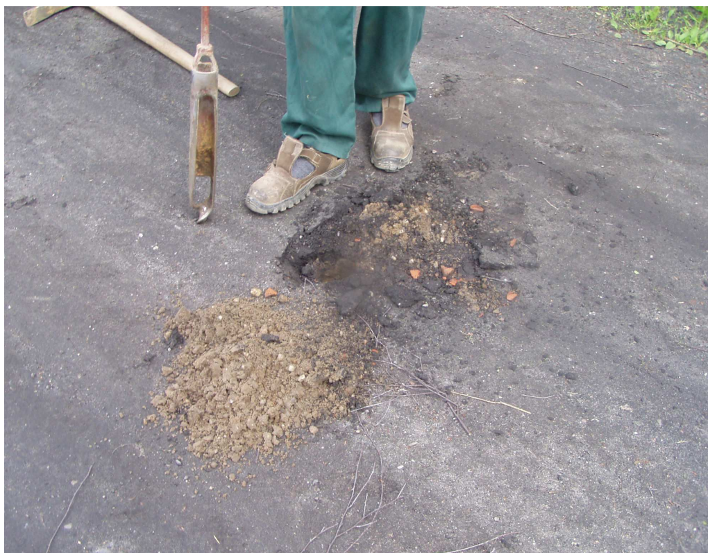
Wykonywanie odwiertów w istniejącej nawierzchni drogi Odwiert nr 5 str. L, km 0+950
