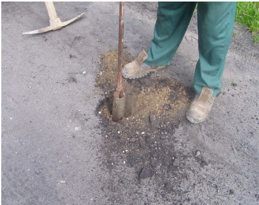
Wykonywanie odwiertów w istniejącej nawierzchni drogi Odwiert nr 4 str. P, km 0+750
