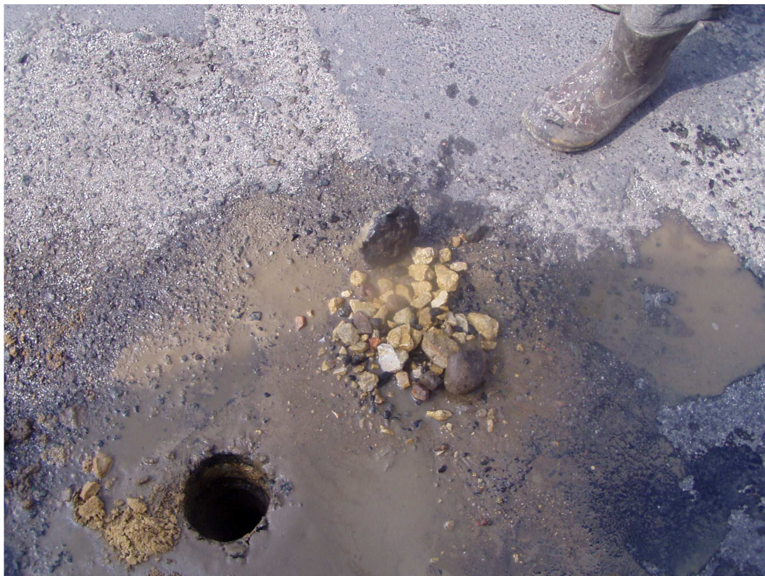
Odwiert nr 3 ul. Plac Targowy przy postoju autobusów nawierzchnia bitumiczna gr. 4cm, kruszywo łamane gr. 15cm
