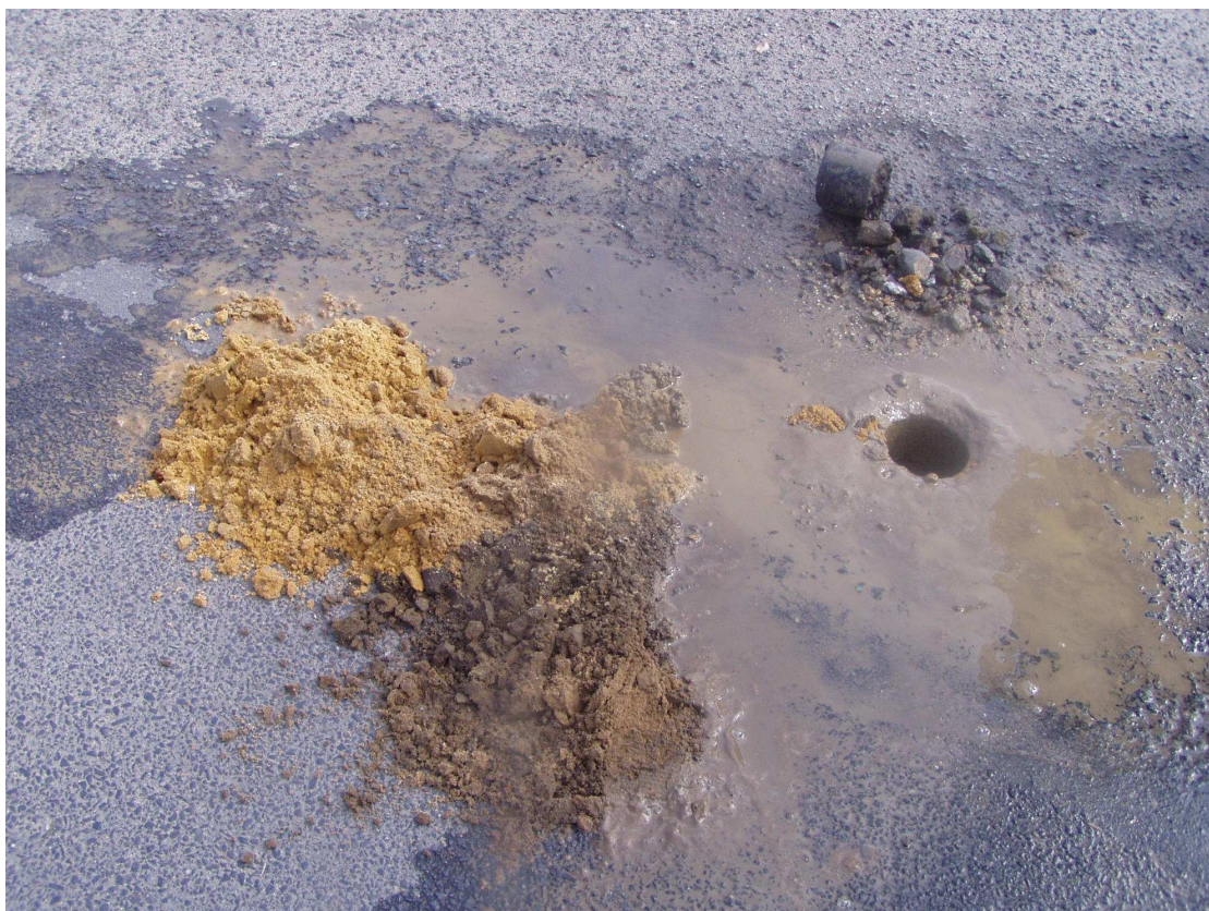
Odwiert nr 4 ul. Plac Targowy
