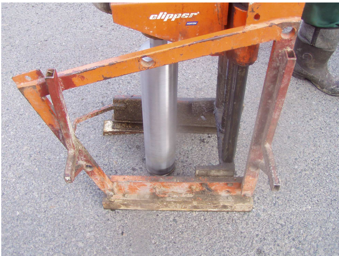
Wykonywanie odwiertów w istniejącej nawierzchni Odwiert nr 1 Parking pomiędzy ul. Wojska Polskiego i ul. Oleśnicką
