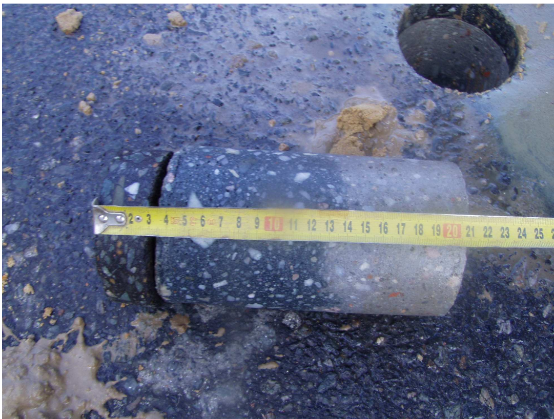
Odwiert nr 1 Parking pomiędzy ul. Wojska Polskiego i ul. Oleśnicką Nawierzchnia bitumiczna i betonowa gr. 3cm+ 18cm
