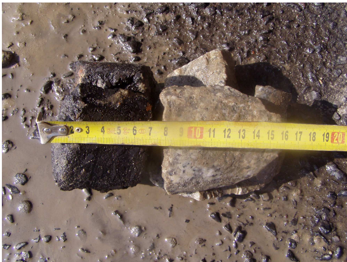
Odwiert nr 2 ul. Wojska Polskiego Nawierzchnia bitumiczna gr. 7cm, kostka granitowa gr. 12cm
