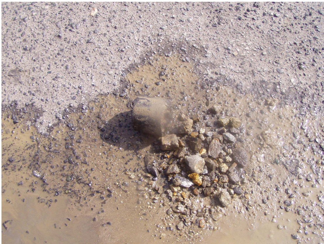
Odwiert nr 4 ul. Plac Targowy nawierzchnia bitumiczna gr. 10cm, kruszywo łamane gr. 15cm
