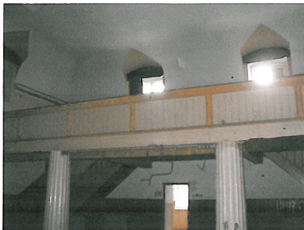
Fot. 8 – Widok na antresolę w budynku Nr 1.
