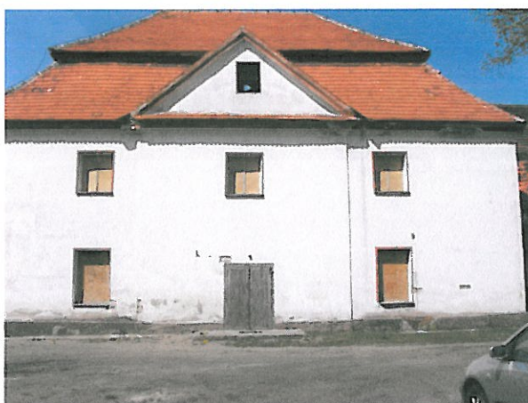
Fot. 2 – Elewacja frontowa budynku Nr 1.
