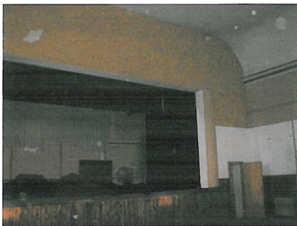
Fot. 9 – Widok na scenę w budynku Nr 1.
