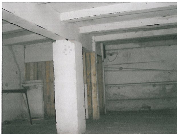
Fot. 12 – Strop drewniany pod sceną w budynku Nr 1.
