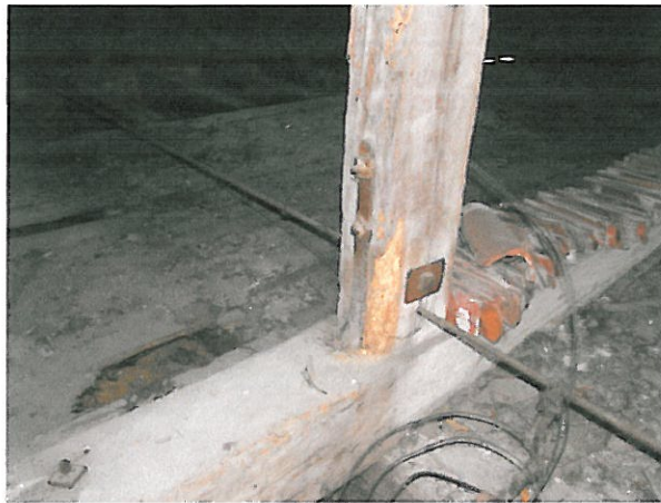
Fot. 24 – Słup podwieszony, dźwigający podwalinę i ściagi mocowane w słupie zabezpieczające rozchodzenie się więźarów dachowych w budynku Nr 1.
