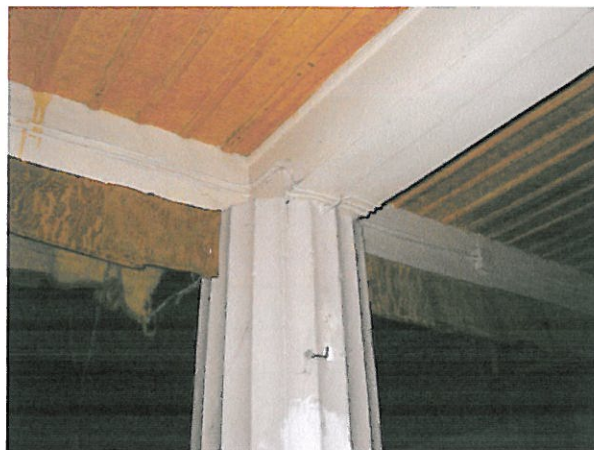
Fot. 11 – Podparcie antresoli w budynku Nr 1.
