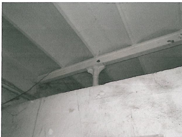
Fot. 14 – Konstrukcja nośna stropu w budynku Nr G ( słupy żeliwne, podciagi z I280 i belki stropowe dwuteowe ze sklepieniem odcinkowym).
