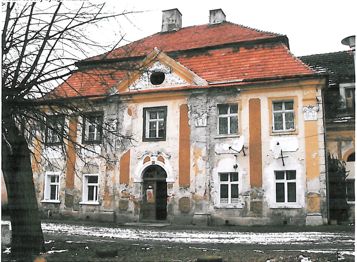
2. Stan obecny byłego budynku gościnnego (obecnie mieszkania po PGR) o zachowanym detalu barokowym nie objęte opracowaniem.
