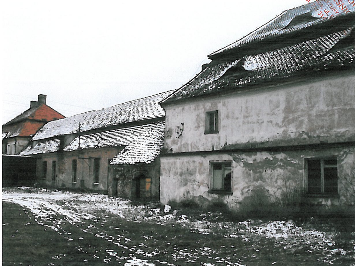
3. Widok elewacji 2 od tyłu.
