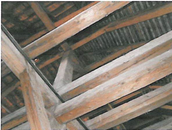
Fot. 27 – Widok na górną część więźby dachowej w budynku Nr 1.
