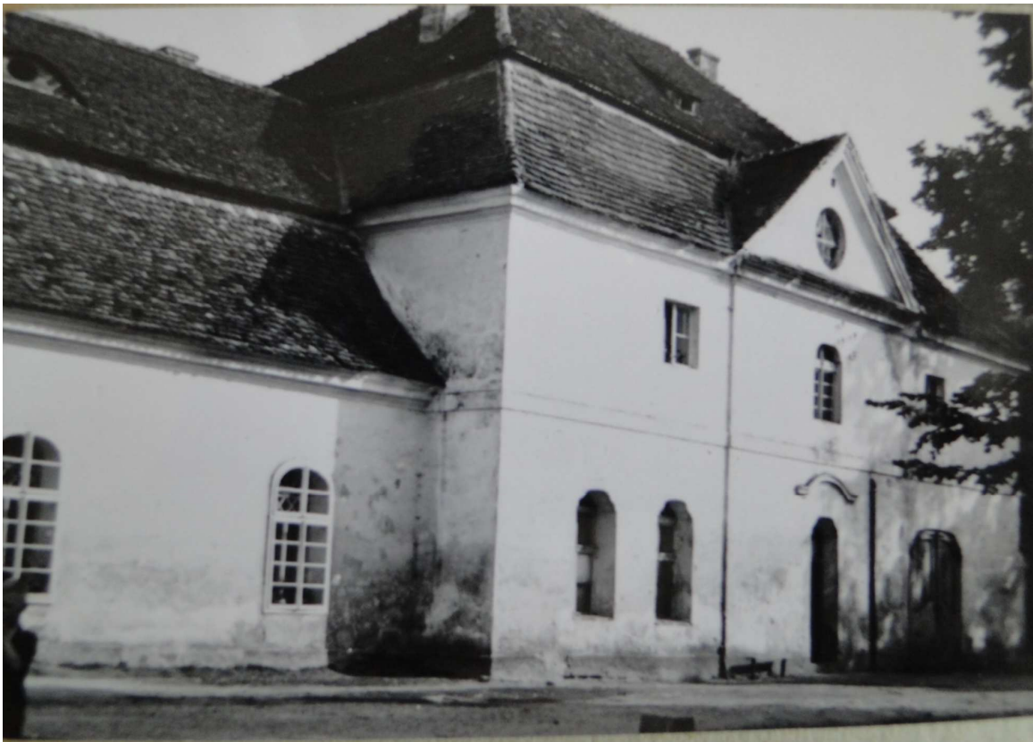
5. Foto elewacji przeciwnego symetrycznego skrzydła założenia karta zabytku lata 60 XXw .
