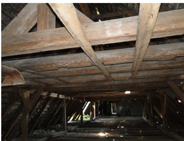
Fot. 21 – Widok na konstrukcję więźby dachowej w budynku Nr G.
