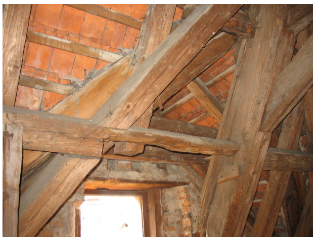
Fot. 38 – Wycięte elementy więźby dachowej przy wykonanym otworze w ścianie budynku Nr 1.
