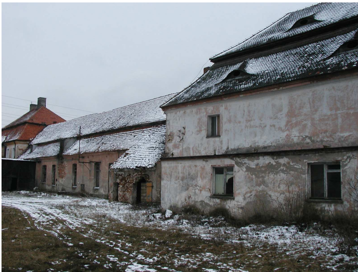
3. Widok elewacji 2 od tyłu.
