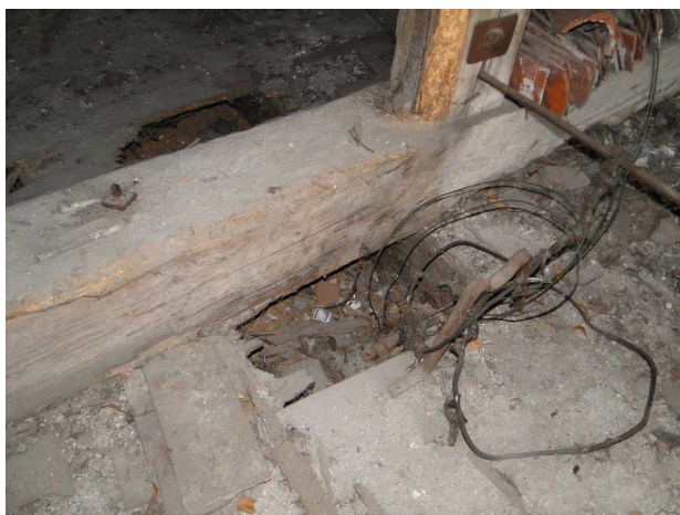
Fot. 23 – Podwalina z podwieszanymi belkami stropowymi w budynku Nr 1.
