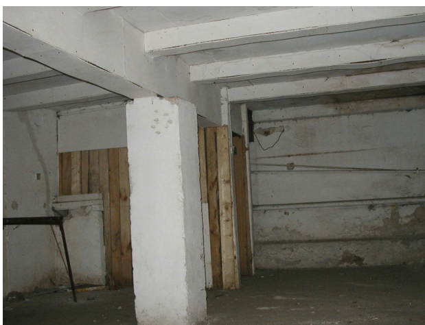
Fot. 12 – Strop drewniany pod sceną w budynku Nr 1.
