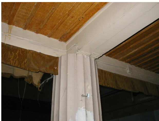
Fot. 11 – Podparcie antresoli w budynku Nr 1.
