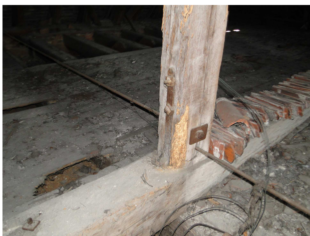
Fot. 24 – Słup podwieszony, dźwigający podwalinę i ściagi mocowane w słupie zabezpieczające rozchodzenie się wiązarów dachowych w budynku Nr 1.
