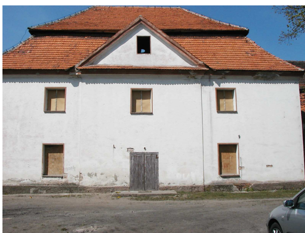
Fot. 2 – Elewacja frontowa budynku Nr 1.
