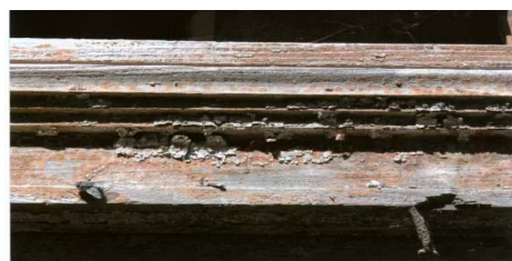
WIDOK ŚLEMIENIA OKIEN foto oryginał 08 2011 w każdym oknie do odtworzenia
