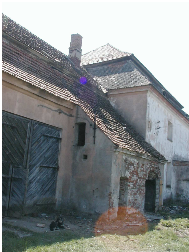
Fot. 4 – Dobudówka na styku budynków Nr 1 i Nr G do rozbiórki.
