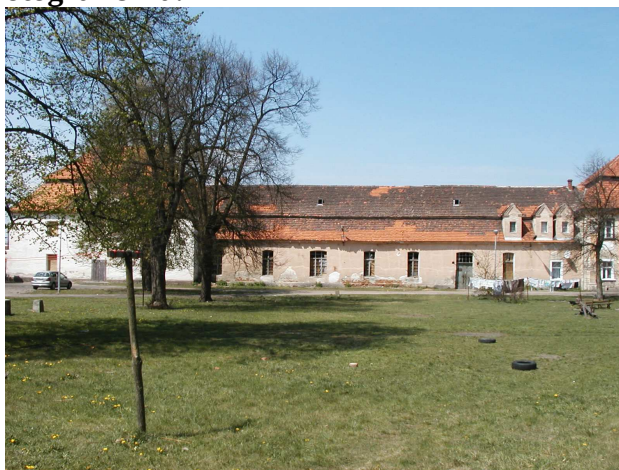
Fot. 1 – Elewacja frontowa dwóch budynków Nr 1 i Nr G.
