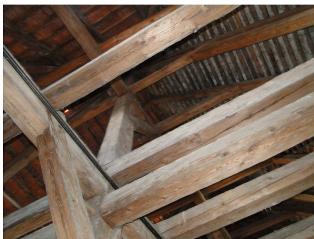
Fot. 27 – Widok na górną część więźby dachowej w budynku Nr 1.
