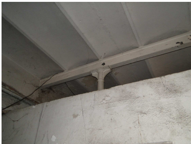
Fot. 14 – Konstrukcja nośna stropu w budynku Nr G ( słupy żeliwne, podciąg z I280 i belki stropowe dwuteowe ze sklepieniem odcinkowym).
