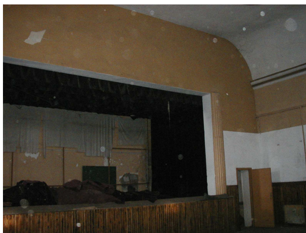
Fot. 9 – Widok na scenę w budynku Nr 1.
