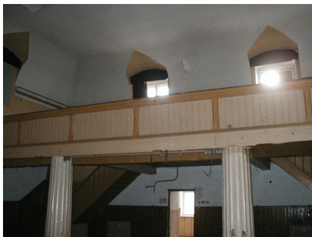
Fot. 8 – Widok na antresolę w budynku Nr 1.
