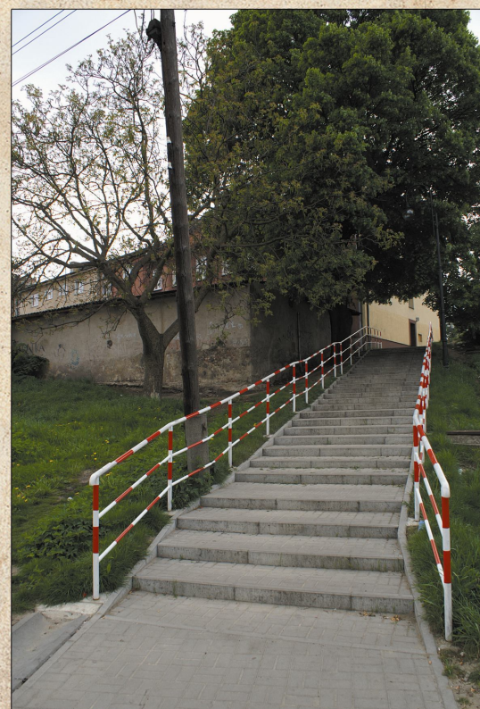
WIDOK Z CZĘŚCI CENTRALNEJ TERENU W KIERUNKU CENTRUM MIASTA
