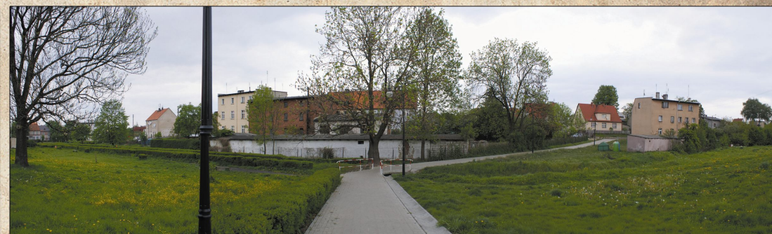
WIDOK OD STRONY POŁUDNIOWEJ, W TLE MOSTEK
